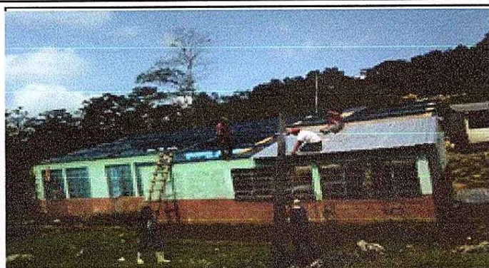
desinstalacion lamina modulo 1
